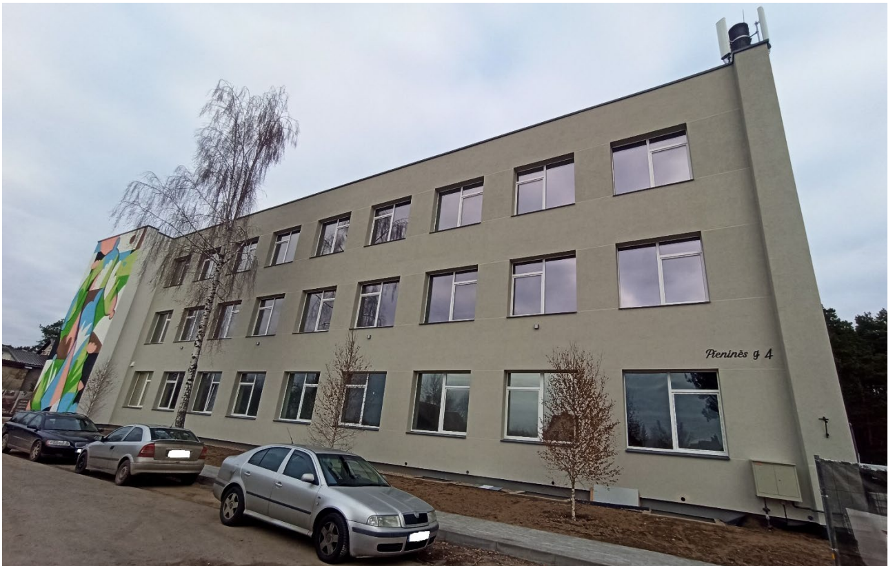
6 pav. Pastato fasadas nuo Pieninės g. pusės.
